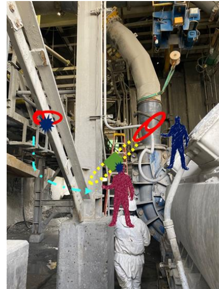
Eslinga de 1TN de capacidad se rompe.
