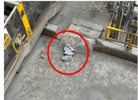
Se observa proyección de roca de 40 cm a nivel inferior a una altura de 5.40 mts.
