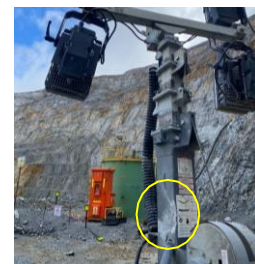
Fig.03.- Daño en mástil de luminaria
