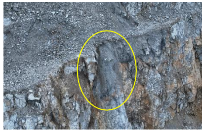
Fig.02.- Cresta desde donde ocurre desprendimiento
